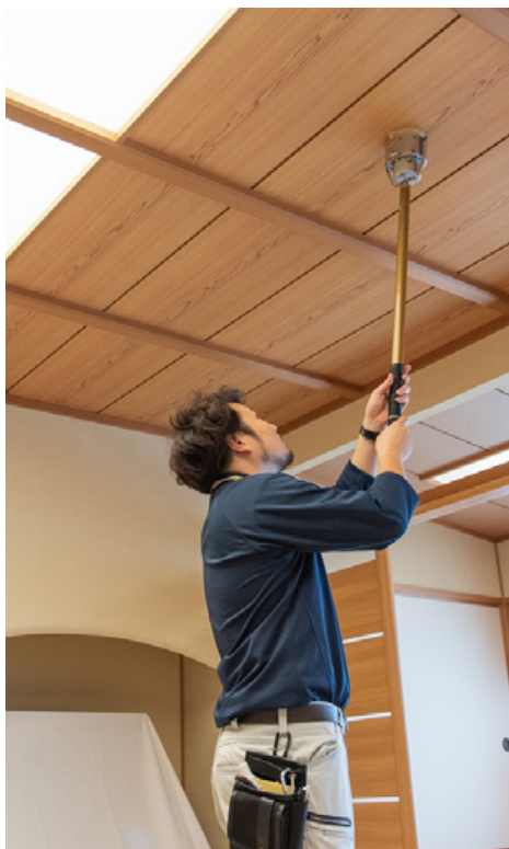
防災機器の交換
